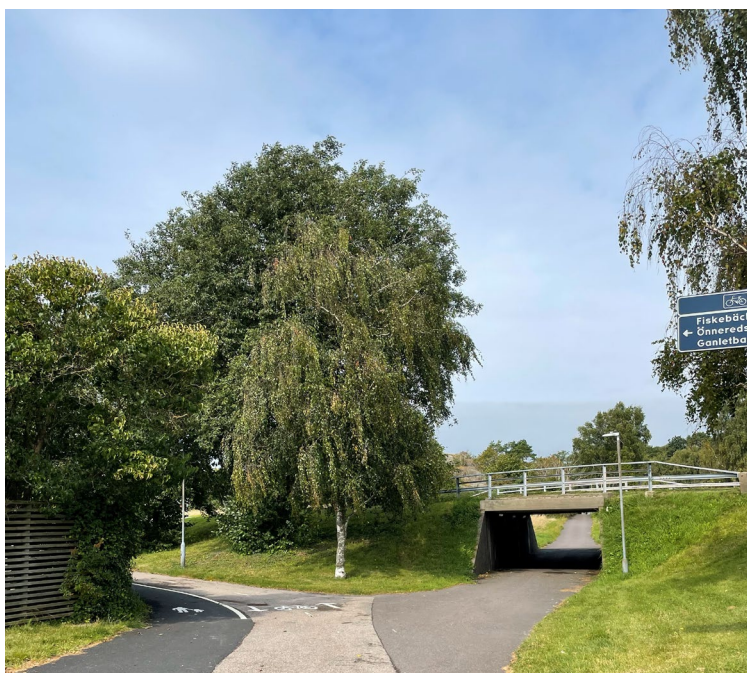
Figur 6. GC-tunnel under Åkeredsvägen. Kamerariktning åt norr.
