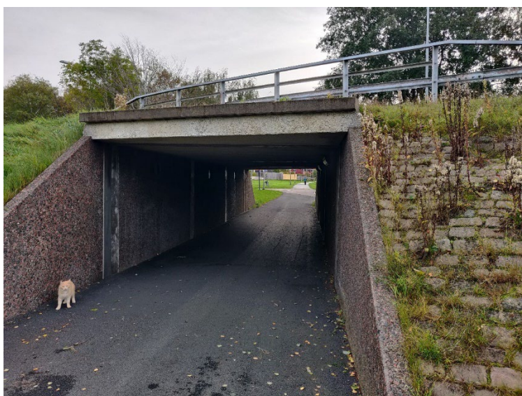
Figur 7. GC-tunnel under Åkeredsvägen.
